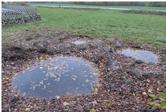
Lw31_2013_MSteffen_2. Foto kurz nach Bau 2013, vor Verbesserung 2014
