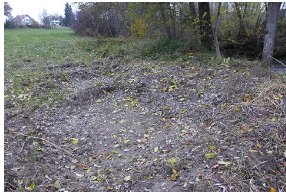
Lw30_2013_MSteffen_1. Foto kurz nach Bau 2013 und vor Verbesserung 2014
