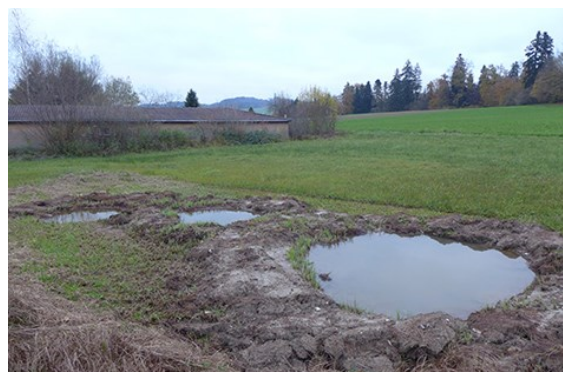
Lw32_2013_MSteffen_1. Foto kurz nach Bau 2013, vor Verbesserung 2014
