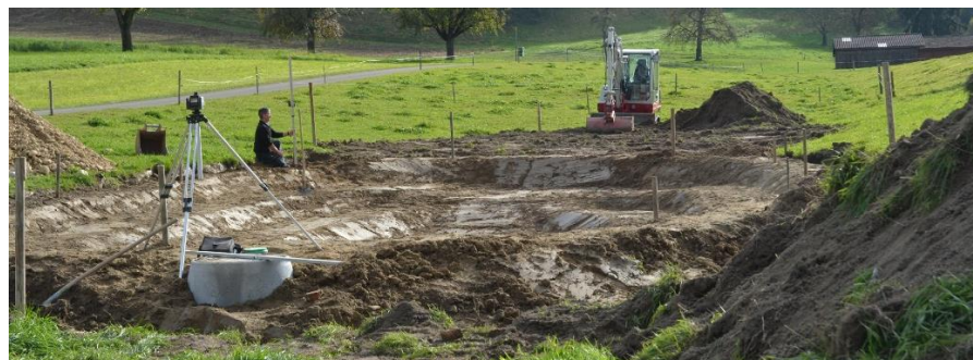
Bau eines Weihers im Rahmen eines Smaragdprojekts. Foto © Biodiversia
